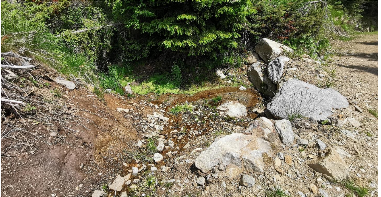
Abb. 3: Entwässerung mit Ausleitung in talseitige Feuchtwiese
