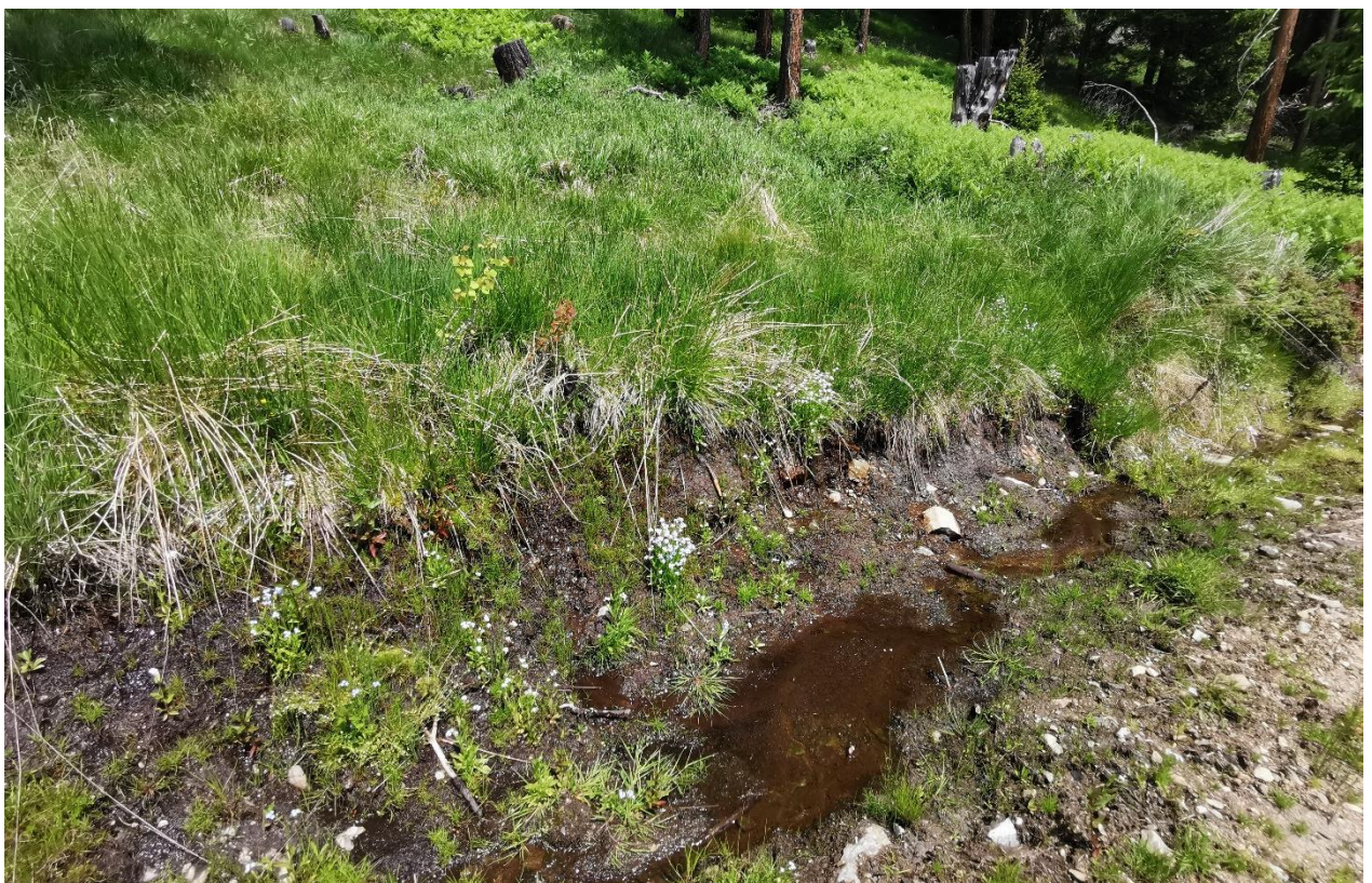
Abb. 2: Feuchtstandort oberhalb des Weges und Wasseraustritt bei der Böschung mit Entwässerung in Spitzgraben
