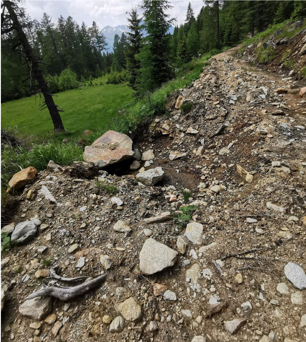
Abb. 6: Endbereich der Umbaustrecke
