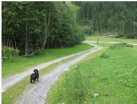
Abb.1. Wirtschaftsweg mit Schotterdecke und begrüntem Mittelstreifen (Spurwege)
