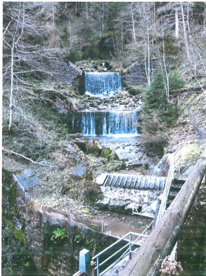
Bestehende Wehranlage unterhalb des neu geplanten Vorhabens mit Volleinzug.
